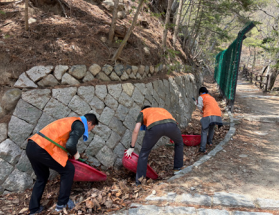
불국사 배수로 정비작업
